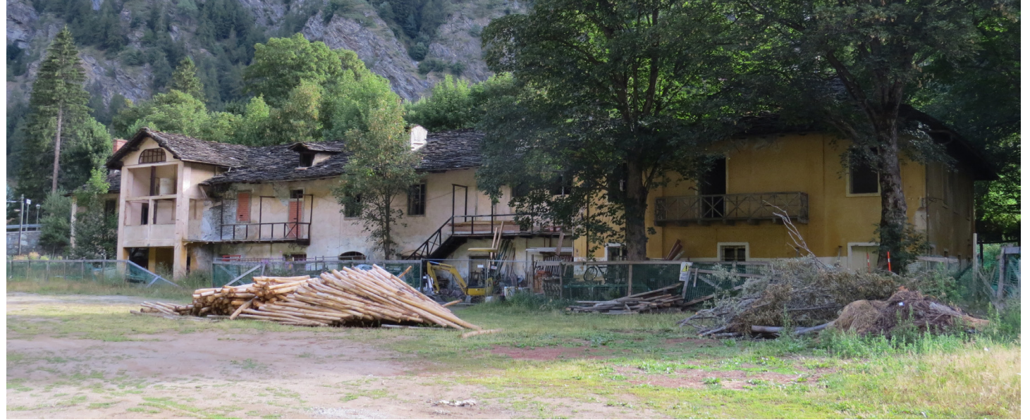
Vista generale Edificio 1
