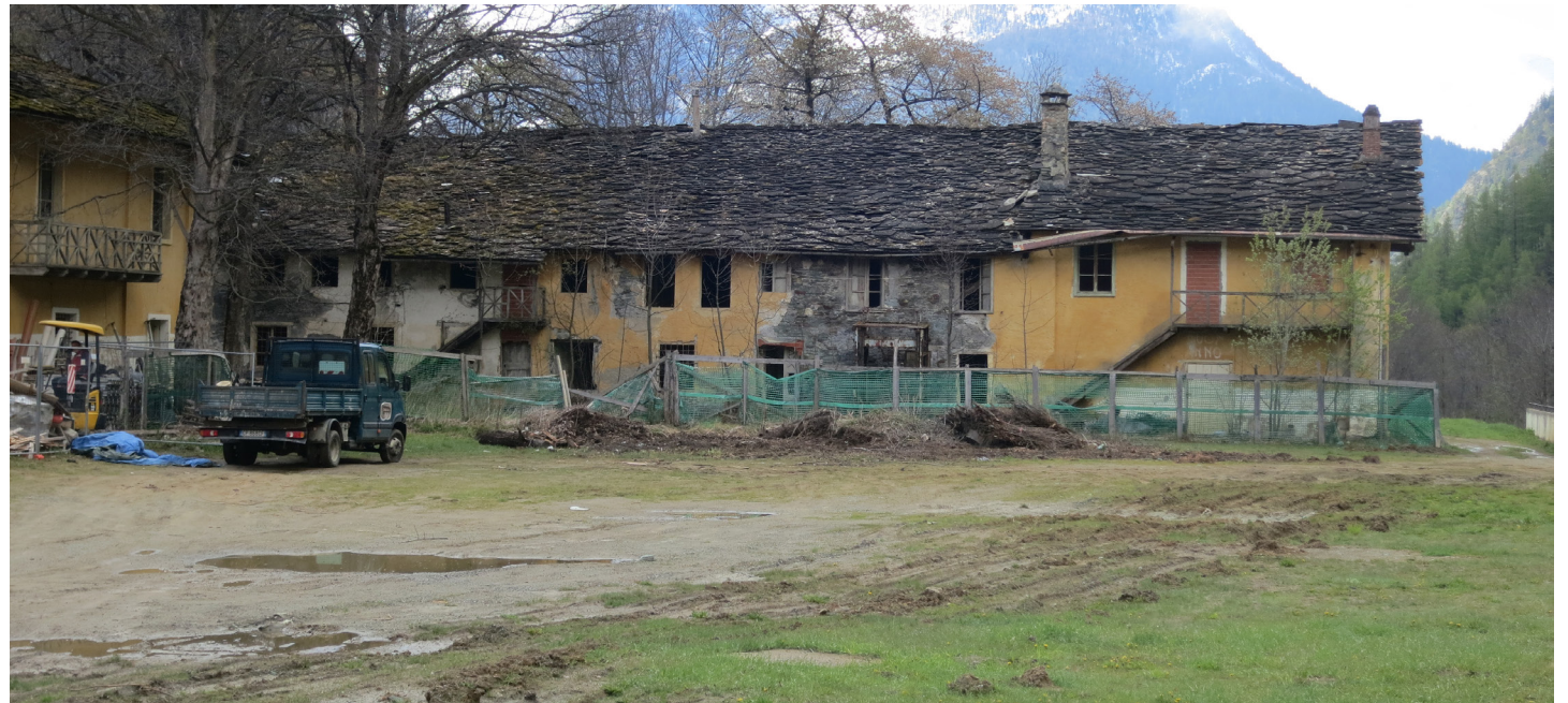
Vista generale Edificio 2
