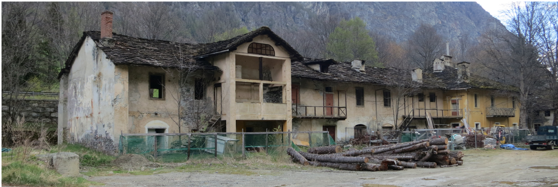
Vista generale dell'Edificio 1 (sopra) e interno (sotto).
